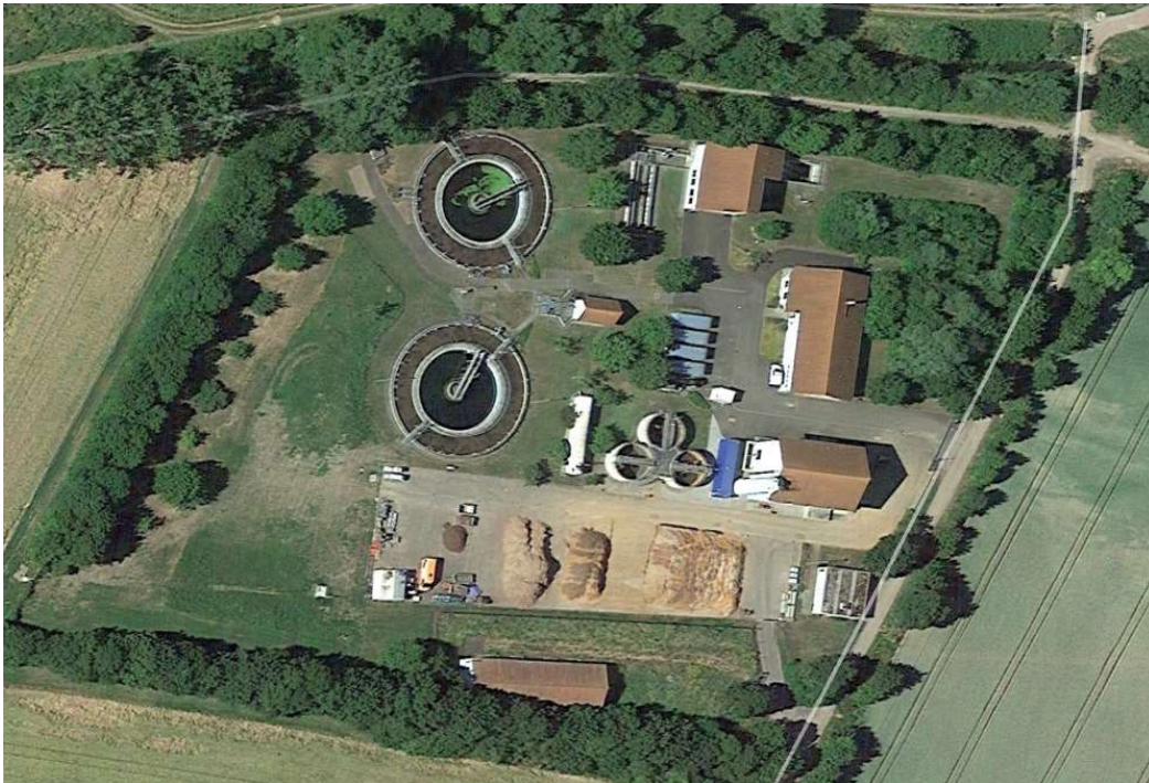
Abb. 2: Luftbild Kläranlage Gau-Bickelheim
