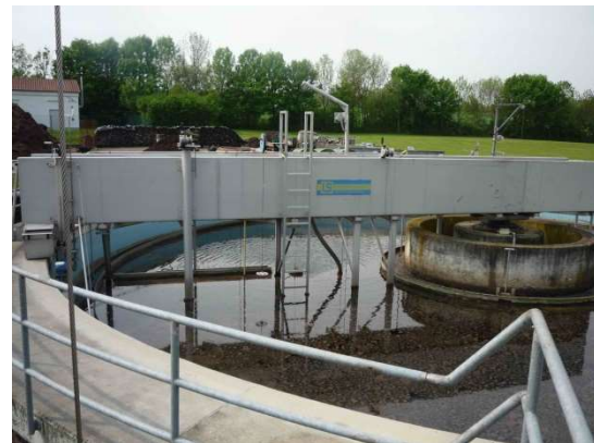
Abb. 8 und Abb. 9 : Belebungs- und Nachklärbecken
