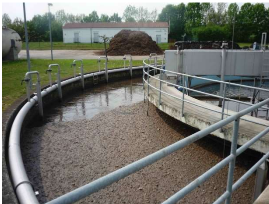
Abb. 8 und Abb. 9 : Belebungs- und Nachklärbecken
