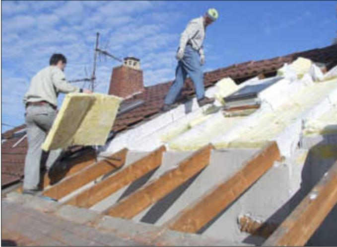
Wenn das Dach neu eingedeckt werden muss, ist es Zeit, die Dämmung zukunftsfähig zu machen. Spätestens jetzt muss sie den Anforderungen der Energieeinsparverordnung genügen. Hier: Zwischensparrendämmung aus Mineralwolle. Foto: VZ RLP
