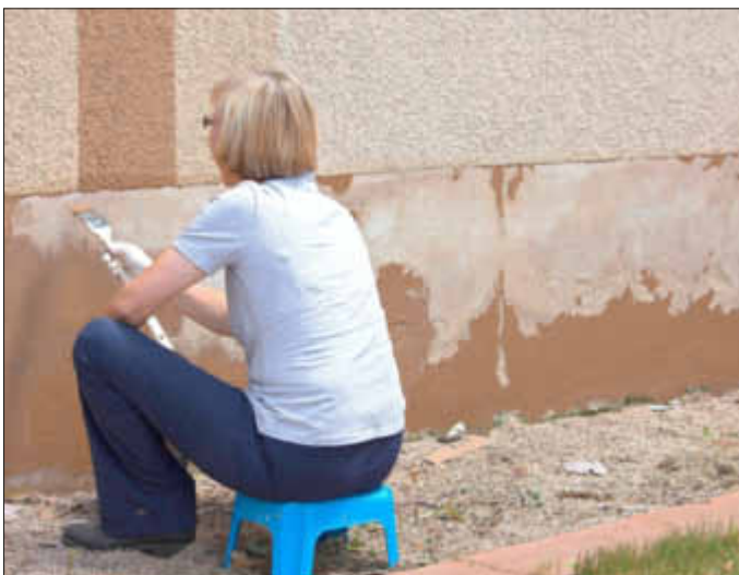
Unter der Anleitung der 1. Beigeordneten, Frau Beate Wridt, fanden sich einige Eckelsheimer zu einer kosmetischen Erste-Hilfe-Aktion zusammen. Die Sockelumrandung als auch die Toilettentüre erhielten einen neuen Anstrich.
