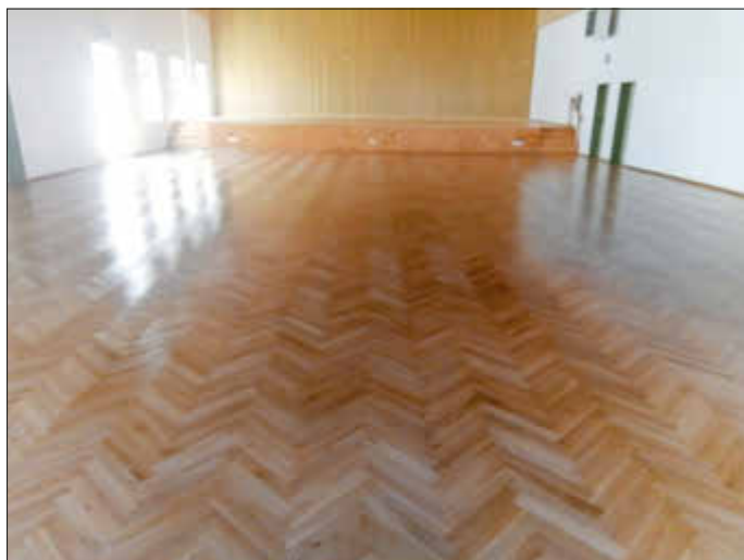
Das abgeschliffene und frisch lackierte Parkett.
