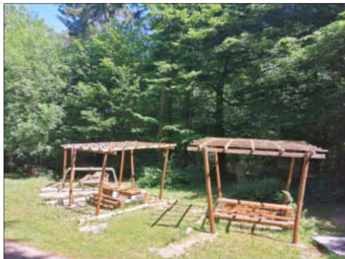
Pavillons, nur noch das Gerüst steht, Dach und Einfassung - neu, frischer Anstrich Bänke und Tische
