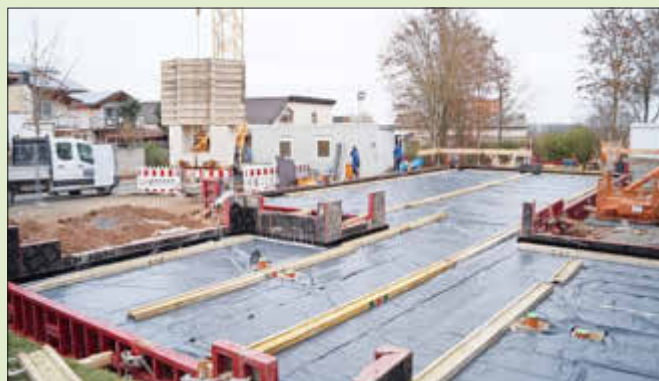
(Bauarbeiten für die neue Mensa der Grundschule in Siefersheim)
