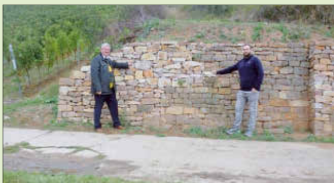
(Bürgermeister Gerd Rocker und der Verwaltungsmitarbeiter Kai Steinmetz an einer der sanierten Trockenmauern)
