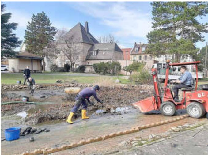
Der Teich wurde komplett abgelassen, unter Zuhilfenahme eines Pumpenfahrzeugs wurde der gesamte Schlamm effizient abgesaugt, im Anschluss wurde der Teich wieder mit frischem Wasser befüllt.
